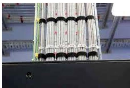
Figure 54: Bon agrafage des câbles verticaux
