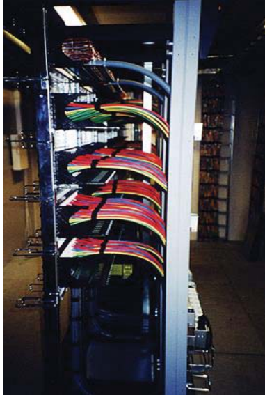
Figure 56: Bonne gestion de câbles dans un rack
