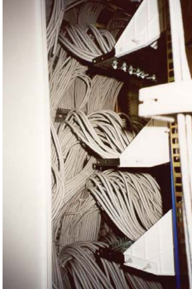
Figure 57: Mauvaise gestion des câbles dans le rack, trop de torons
