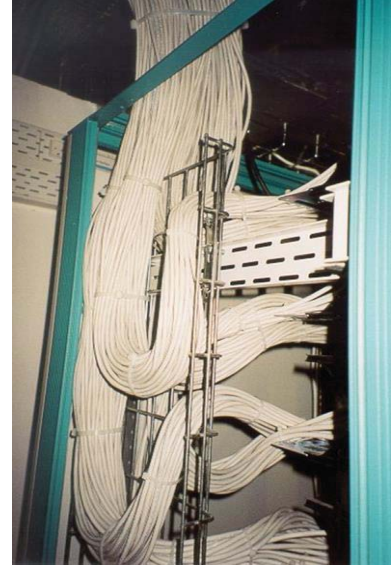
Figure 58: Mauvaise gestion des câbles dans le rack, mauvaise utilisation de guides câbles
